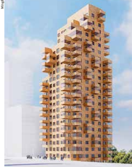
Höghuset i Sundbyberg ska bli 65 meter högt, hysa 22 våningar och helt byggas i gran och furu.
