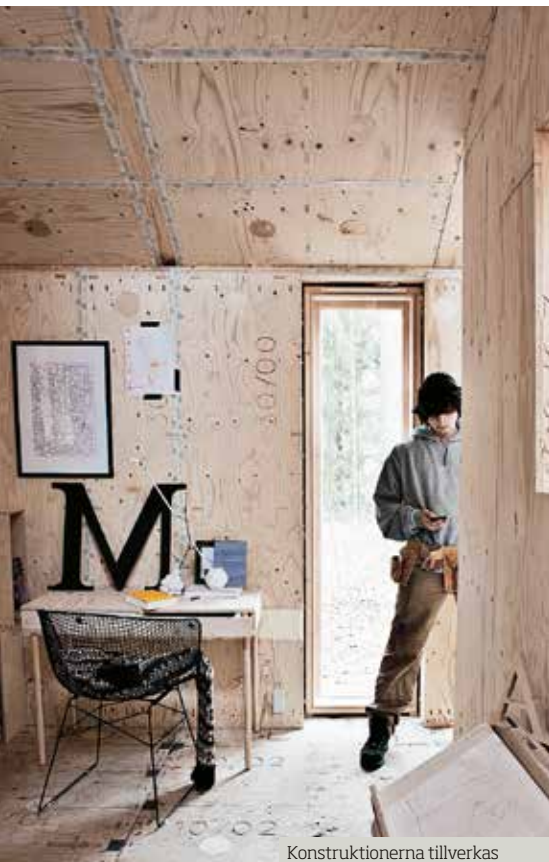
Konstruktionerna tillverkas av träråvara, i huvudsak lätt-konstruktioner i plywood med träfiberisolering samt limträ.
