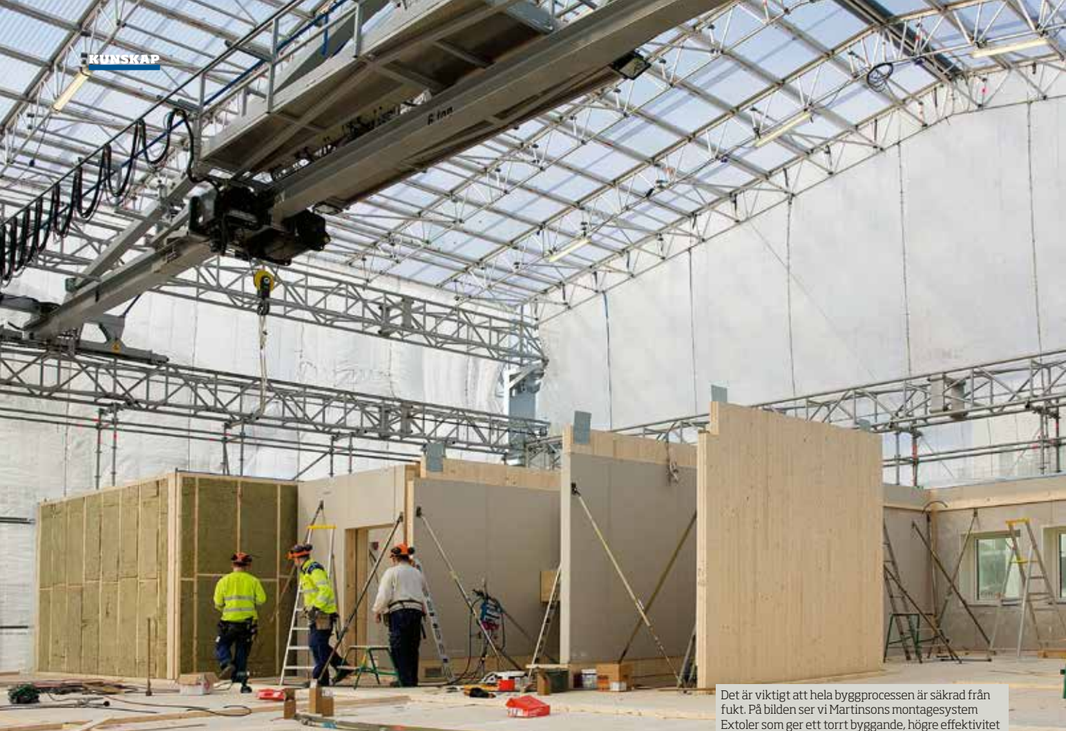
Moelven Töreboda har tillsammans med företaget Boid utvecklat en ny metod för väderskydd som handlar om att täcka över särskilt utsatta och känsliga delar på byggnaden under byggnation.
