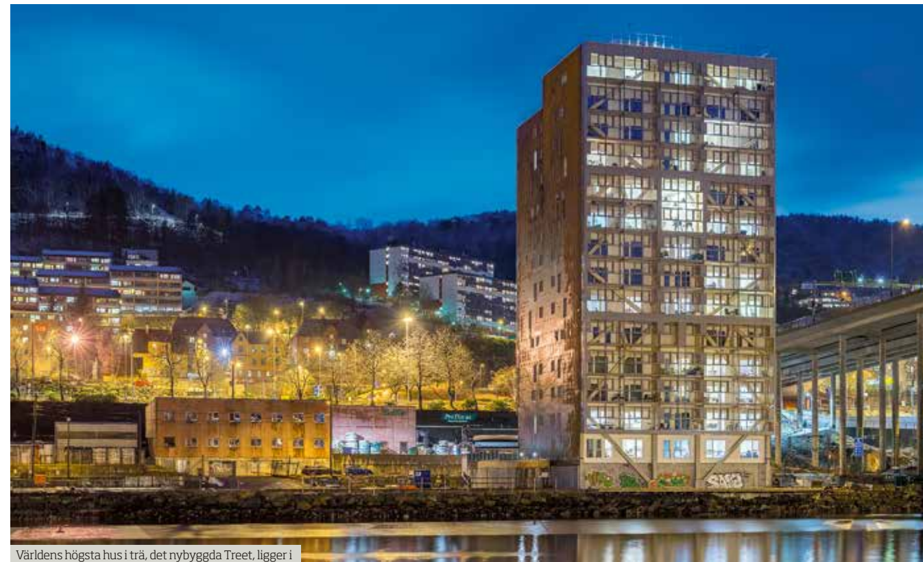
Världens högsta hus i trä, det nybyggda Treet, ligger i Bergen, Norge. Det 45 meter höga huset har en bärande limträstomme och fasad klädd med glas och stål.
