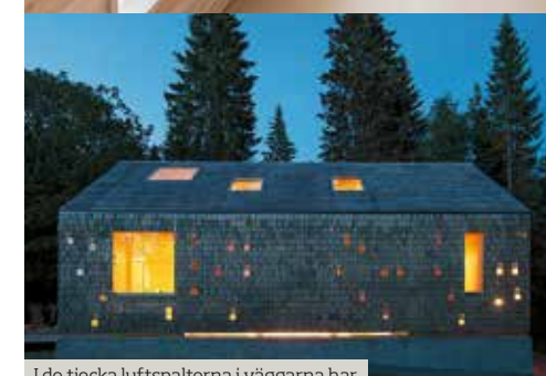
I de tjocka luftspalterna i väggarna har stora nischer placerats som fungerar både som ljusinsläpp och viloplatser.
