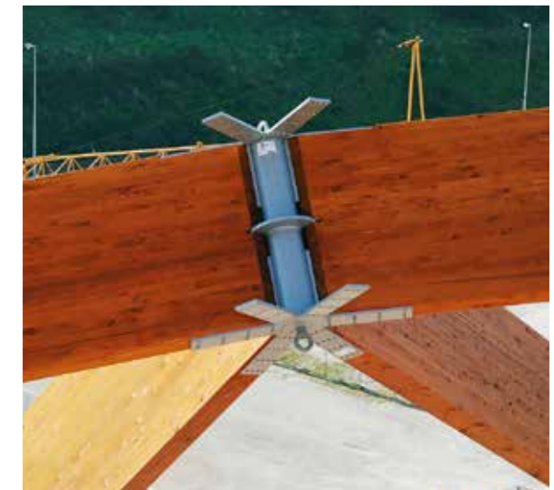
Figur 6. En av de geodetiska träkupolerna i Brindisi under monteringen med detalj av en knutpunkt. Varje delstålplåt försågs med 24 stycken 45-gradershål, avsedda för indragning av 24 stycken 11x450 självborrande träskruvar. Balkhöjden var 1 132 millimeter. Laboratorieförsök utförda vid universitetet i Trento, Italien, visade en momentkapacitet för dessa förband på cirka 900 kNm, vilket motsvarar en lastkapacitet per träskruv på cirka 38 kN.
