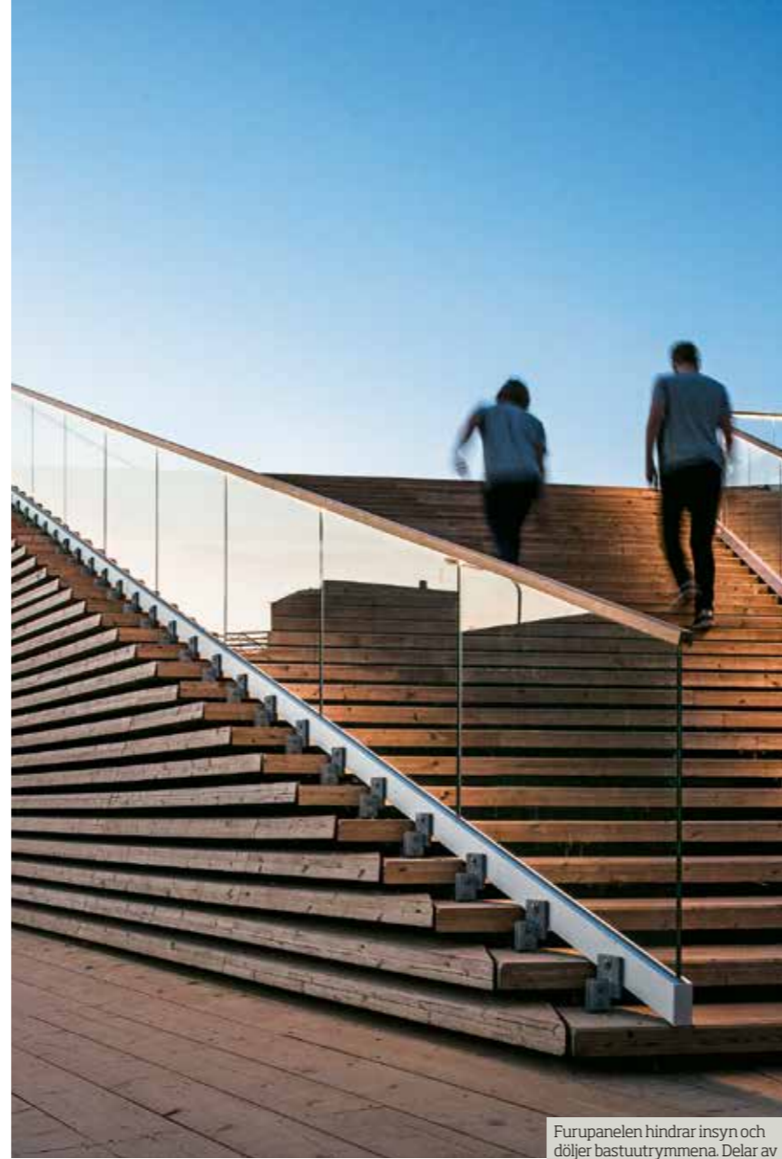
Fasadernas furupanel är monterad på en stålstomme. Panelen är konstruerad så att rester av regn och snö lätt ska kunna rinna av.
