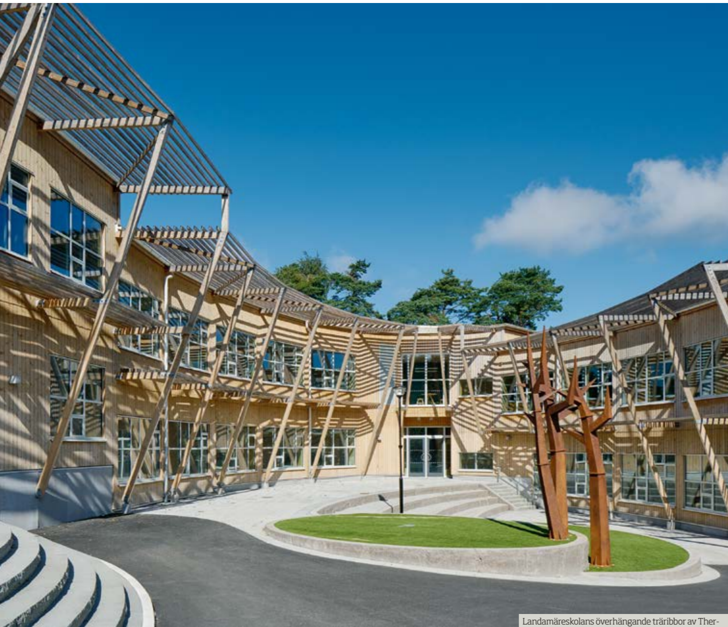
Landamäreskolans överhängande trärribbor av Thermowood skyddar mot solen under den varma årstiden men släpper på vintern in de lågt stående solstrålarna.
