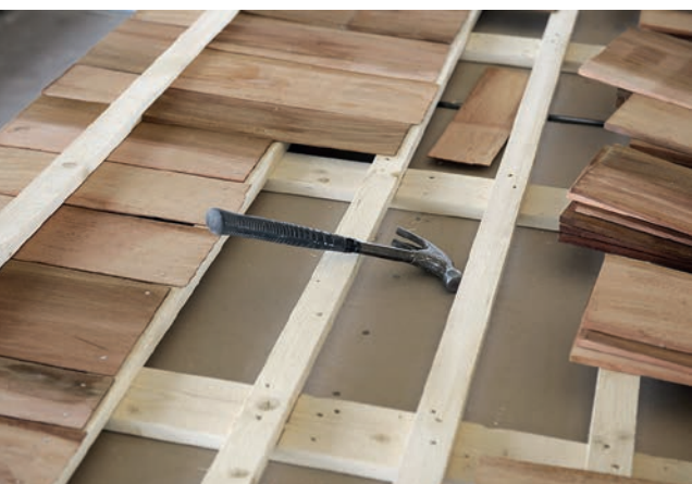
Spikning av element med spån av tuja. Strandparken, Sundbyberg.
