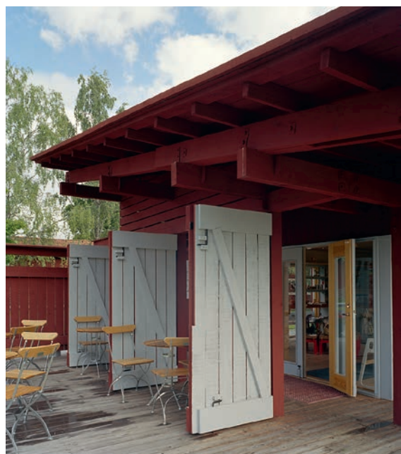
Fasaden är målad med röd slamfärg respektive grå oljefärg. Informationsbyggnad Ornäsloftet, Borlänge, nominerad till Träpriset 2004.
