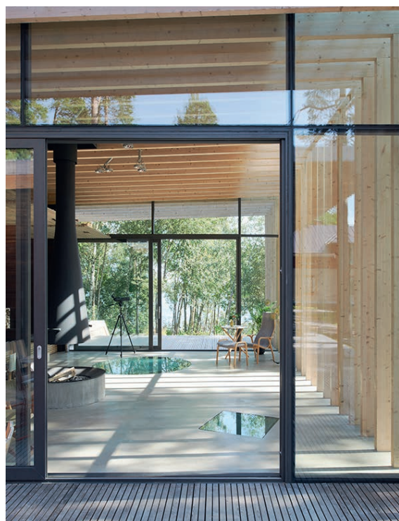
Skogssauna, Tomtebo, Gävle, vinnare av Träpriset 2012. Väggar med linoljelasyr, golv obehandlad kärnfuru, pergolataken i gråvit oljelasyr.
