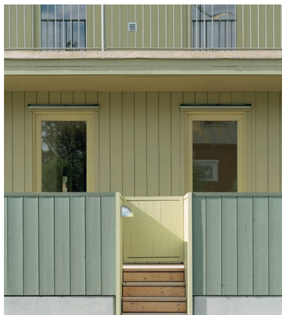
Fasaden är målad med alkydoljefärg. Kvarteret Fiskpigan, Trosa, nominerad till Träpriset 2008.
