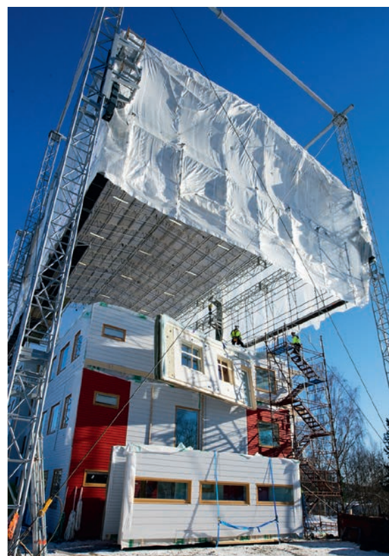
Montering av planelement under väderskydd, Skellefteå. Väderskyddssystem används vid flervåningshus som inte kan monteras färdiga på en dag.
