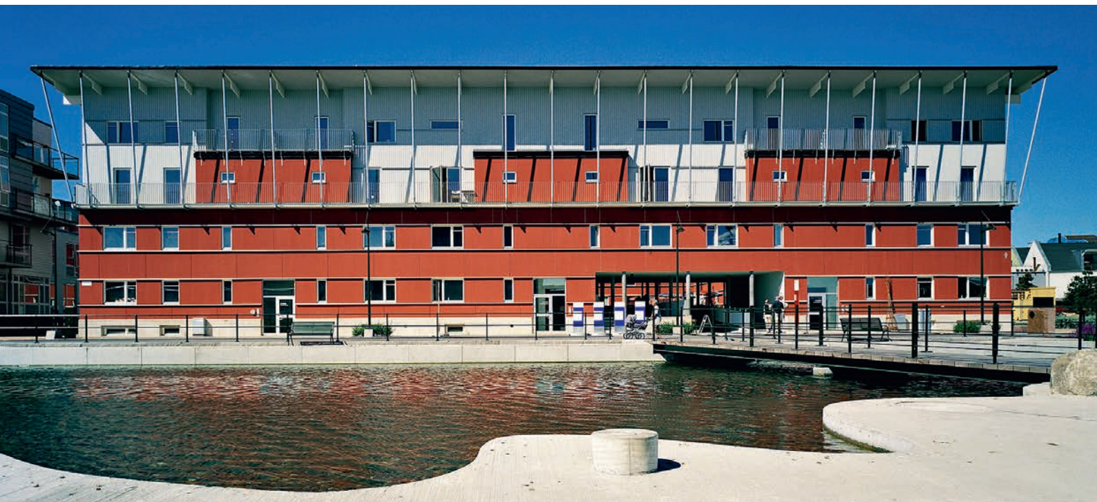
Trähus 2001, Bo 01, Västra hamnen, Malmö.
