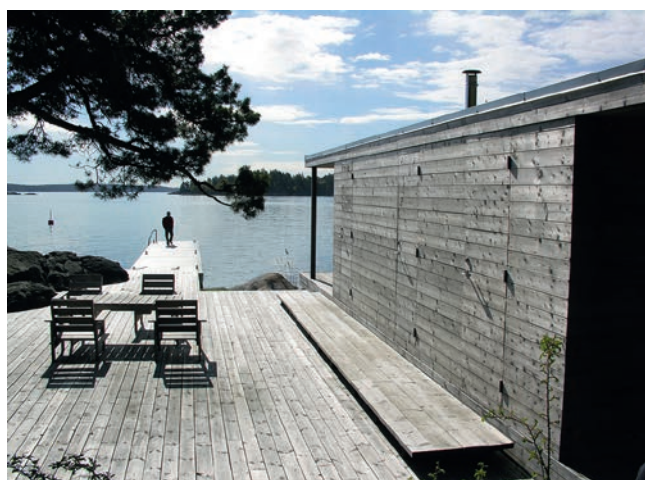
Trädäck och fasad behandlad med järnvitriol.
