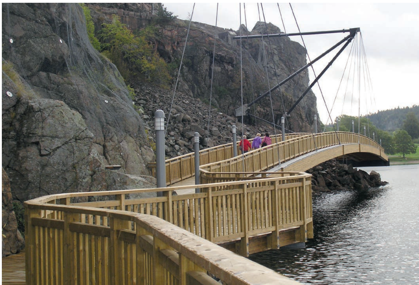
Gångbro av impregnerat trä vid Hästepallarna, Uddevalla.
