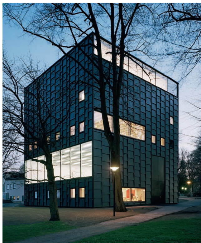
En träfasad på ett hus med en bärande betongstomme är inget trähus, Kalmar konstmuseum, Kalmar.
