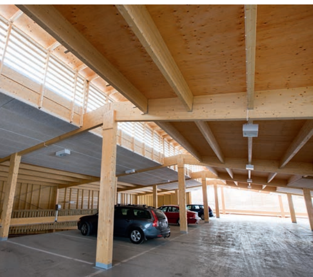
Parkeringshus med stomme av limträ och korslimmat trä, KL-trä, Ekorren, Skellefteå.
