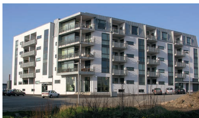
En putsad fasad på ett hus med en bärande trästomme är ett trähus, Rydebäck, Helsingborg.
