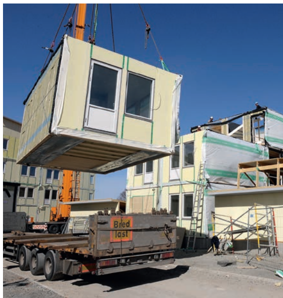
Montering av volymelement. Vinsta, Stockholm.
