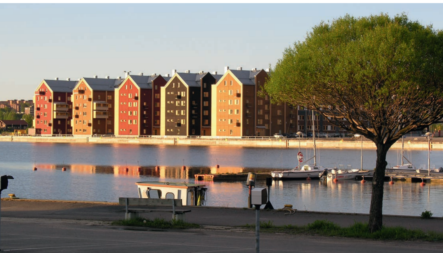
Inre Hamnen i Sundsvall, fem bostadshus med en bärande stomme av korslimmat trä, KL-trä, och träfasad av limträpanel.
