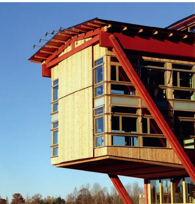
Bjälklag av betong-träkonstruktion, övriga bärande delar i limträ. Kontorshus, Växjö.
