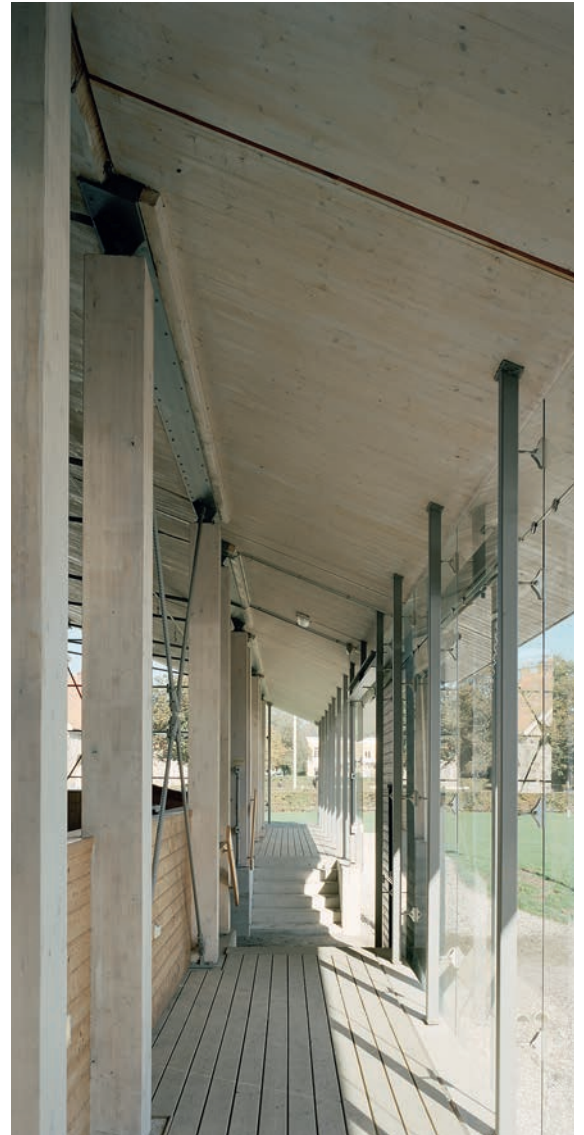
Ridhus, Flyinge, med korslimmat trä, KL-trä i takkonstruktionen, nominerad till Träpriset 2008.
