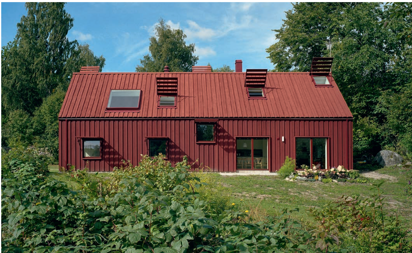
Lockpanel och faltak. Villa Karlsson, Tidö-Lindö, Västerås, nominerad till Träpriset 2004.
