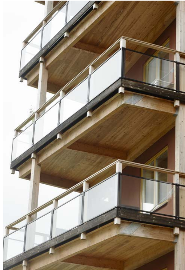
Balconies made of CLT, Växjö, Sweden.
