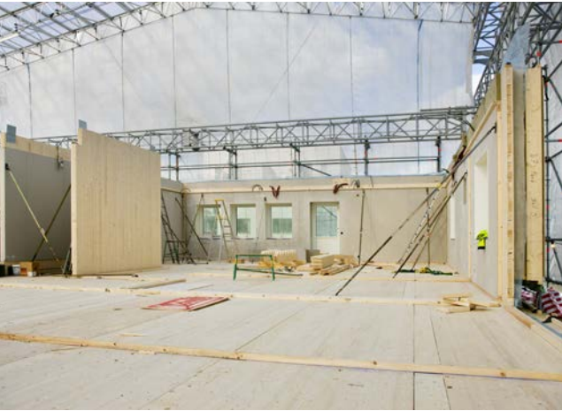
Assembly of walls made of CLT, Portvaktén Växjö, Sweden.
