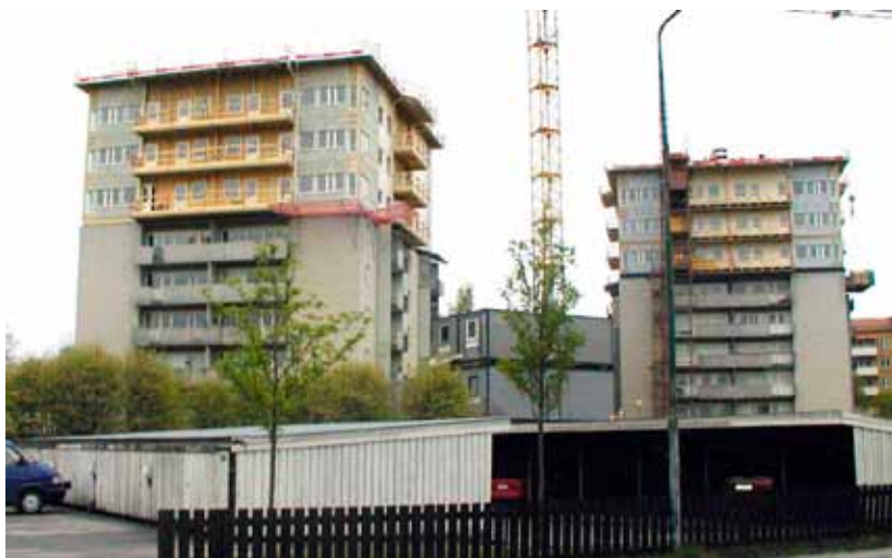
Figur 8 Påbyggnad av 6-våningshus.
