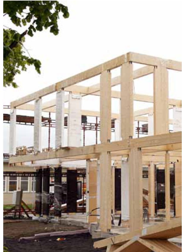
Figur 3 Exempel på pelar-balk-system i limträ.
