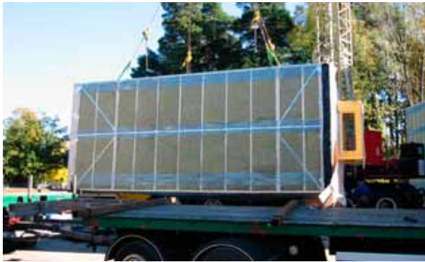
Figur 17 Leverans av volymelement.
