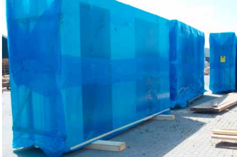
Figur 36 Vädertskyddade väggelement färdiga för leverans.
