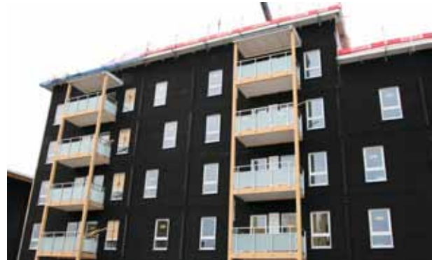
Figur 20 Femvåningshus uppbyggt med volymelement med bärande KL-skivor.
