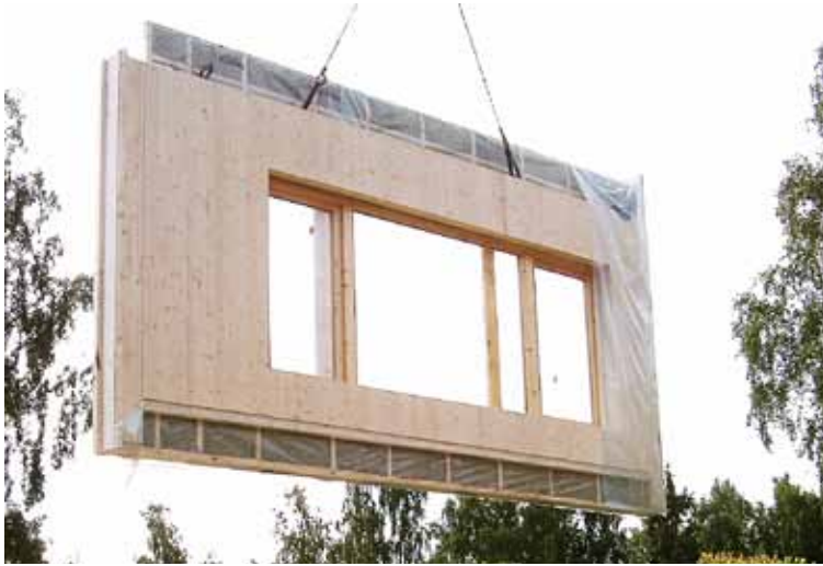
Figur 14 Montage av väggelement med bärande KL-skivor.
