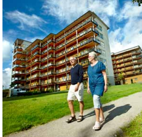
Figur 26 Exempel på putsad fasad, 8-våningshus.
