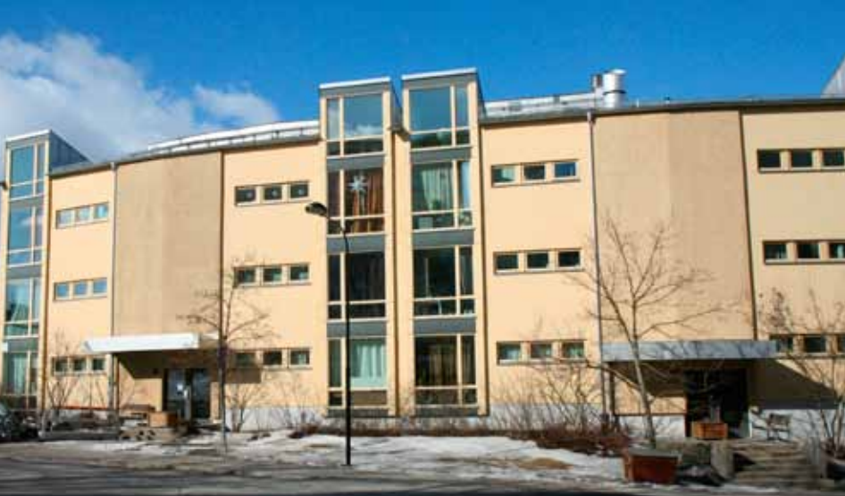
Figur 25 Exempel på putsad fasad, 3-våningshus.
