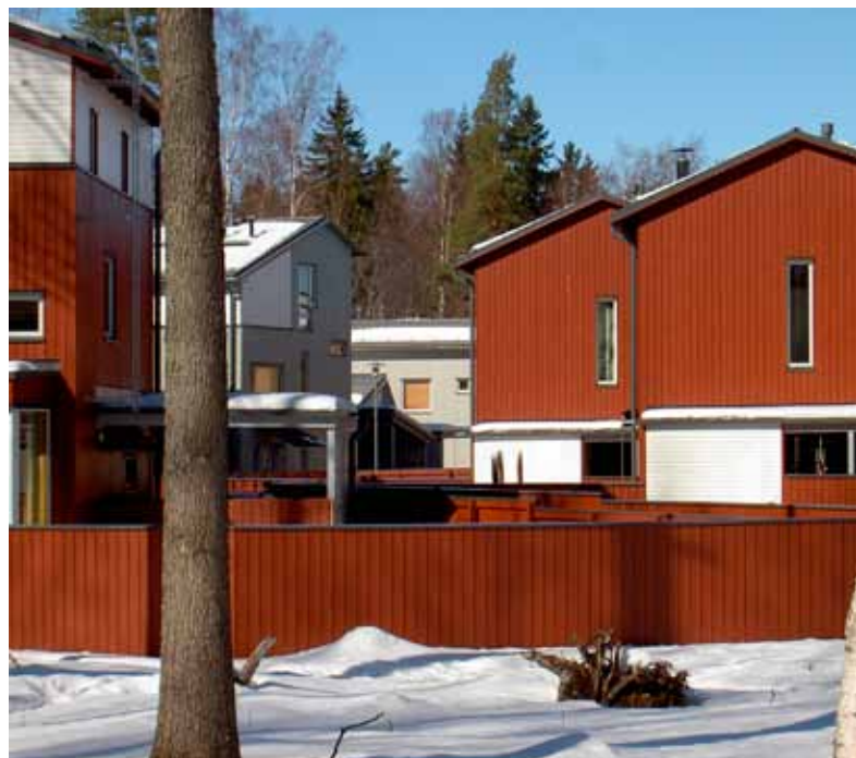
Figur 21 Exempel på grupphus som linoljefärgmålats och där inga skador uppstått på 10 år, medan bredvidliggande hus som målats med alkydolfärg börjat flagna på kortare tid.
