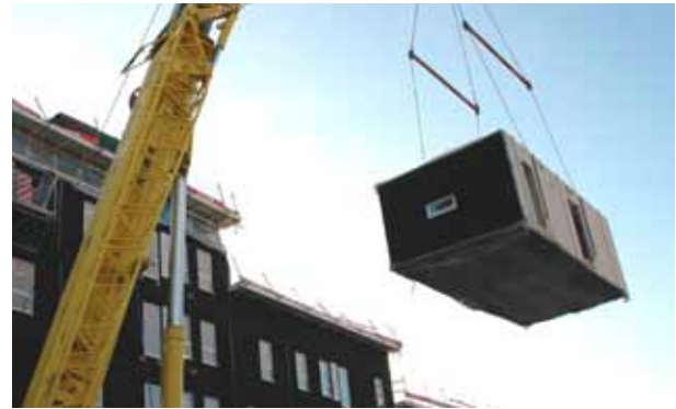
Figur 18 Montage av volymelement.
